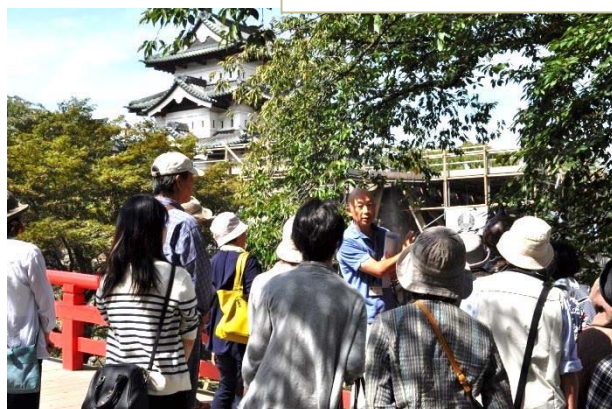
【弘前城石垣修理工事】
