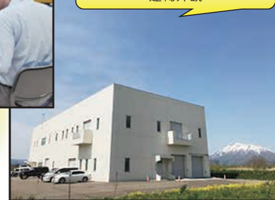
津軽広域クリーンセンター 建物外観
