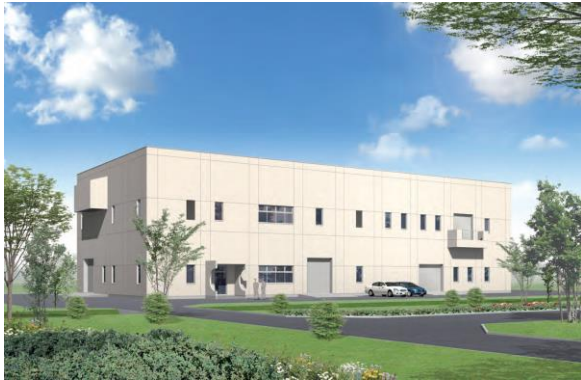
津軽広域クリーンセンター
